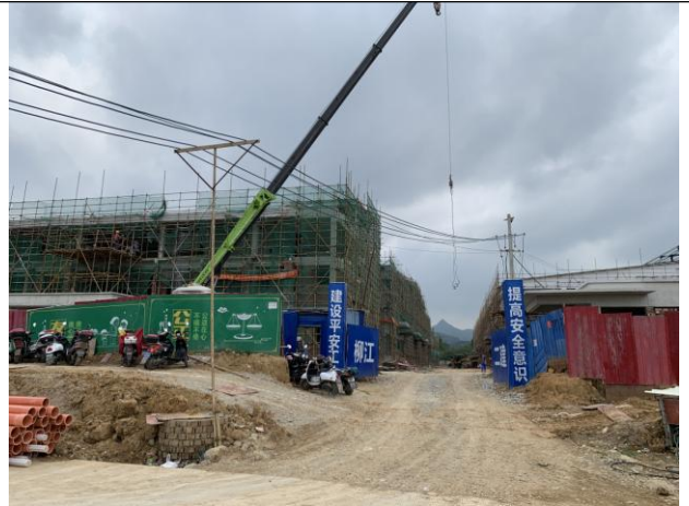
项目南面在建厂房
