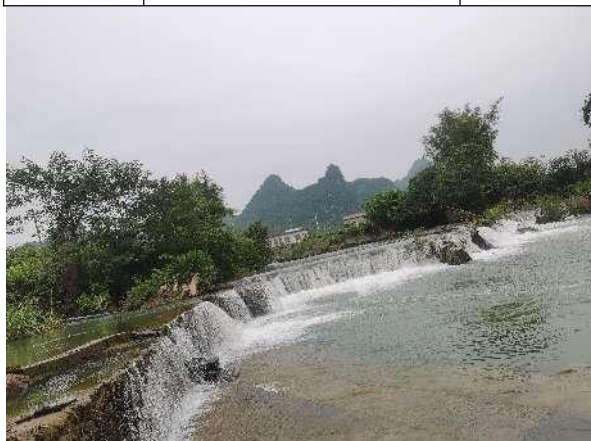
图 1.3-3 新隆村堤防河道
